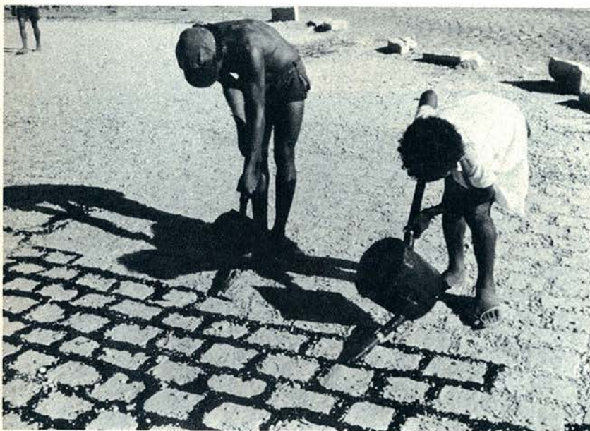
No rejuntamento, uma camada fina de asfalto substituiu o cimento.
