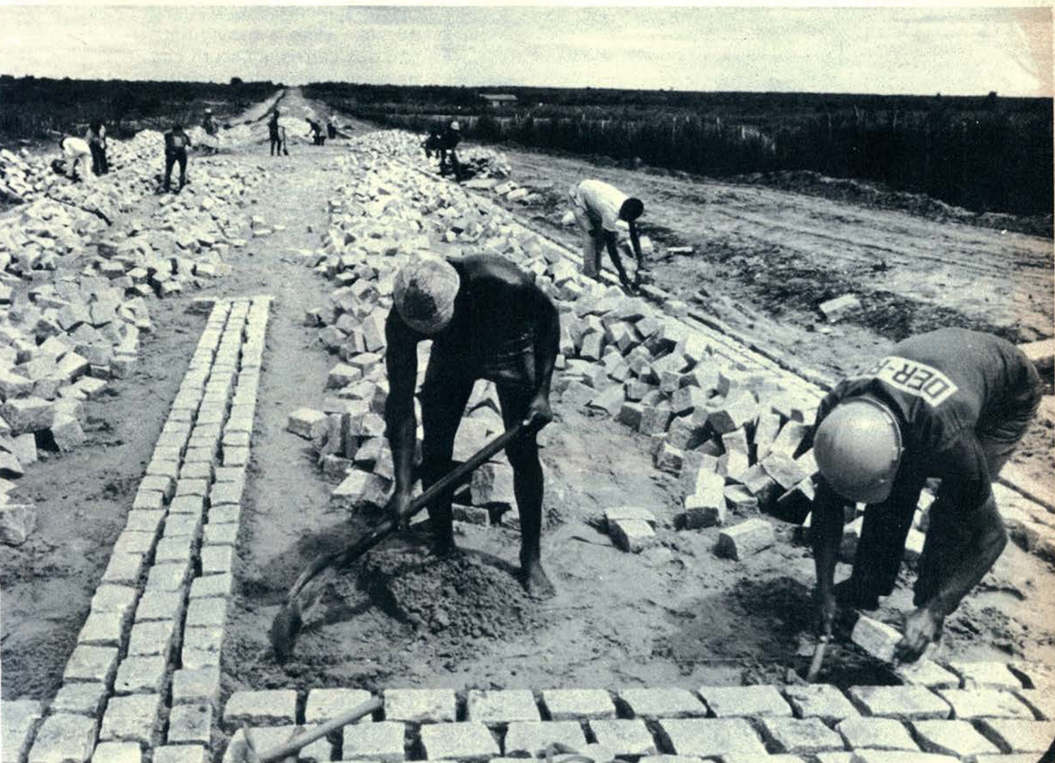
Os paralelepípedos são assentados pelo método tradicional, deixando-se entre as pedras espaçamento de cerca de 3 cm.
