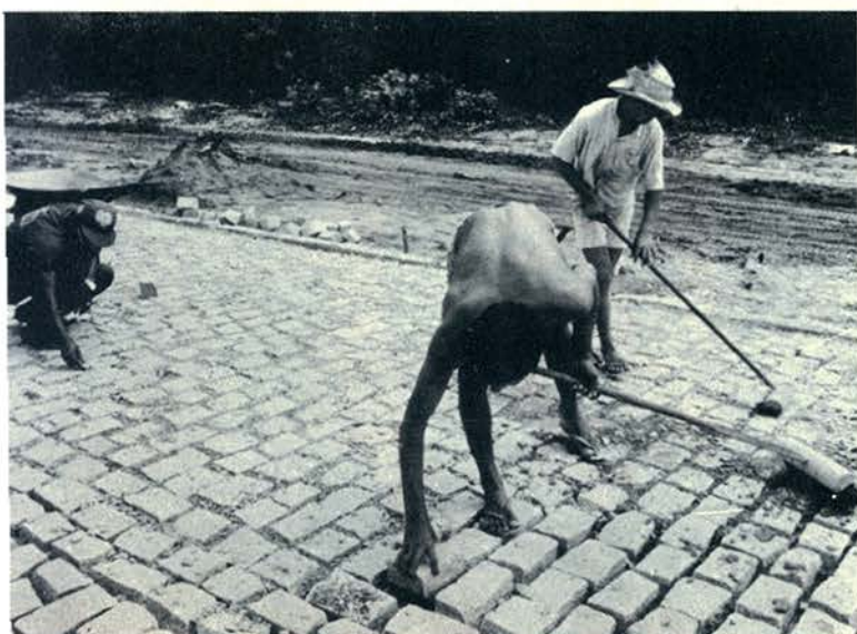
Os vazios são preenchidos com brita fina, espalhada manualmente. A compactação é feita através de rolos de 8 a 10 t.
