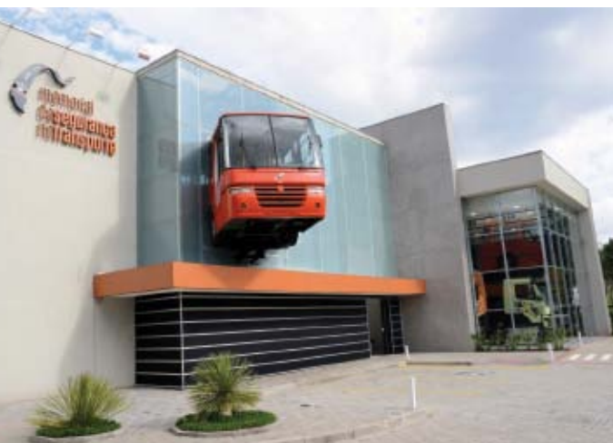
Um ônibus biarticulado suspenso no teto tem sua frente atravessada na parede para compor a fachada
