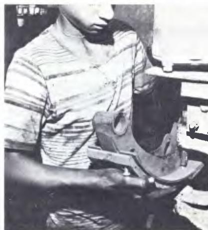
Na Parada Inglesa, o burrinho que é tirado do carro é todo desmontado e polido numa furadeira adaptada; as lonas são rebitadas e desrebitadas por máquinas e os patins alinhados numa prensa
