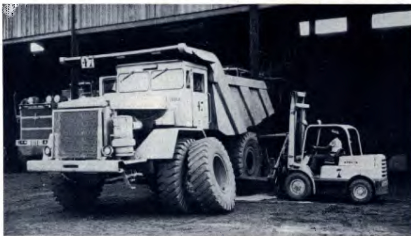
H60J: troca pneus de gigantescos fora-de-estrada e movimenta peças pesadas.
