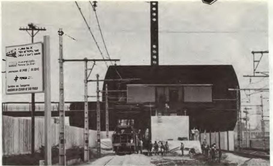
Estação Largo 13 de Maio: construção em aço não corrosivo dispensa pintura
