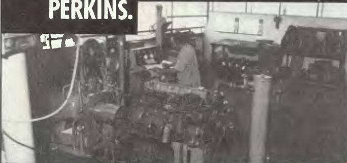
*O dinamômetro testa com precisão e pré amacia TODOS os motores reconicionados.*
