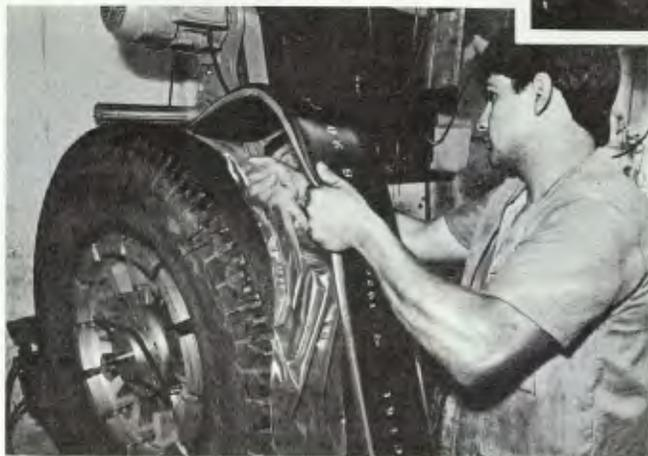
Após a verificação do pneumático e realização de eventuais reparos, a unidade é raspada até que sua superfície torne-se homogênea (acima). Desta forma, o pneu encontra-se pronto para receber a camada de camelback (ao lado), processo final de sua reforma
