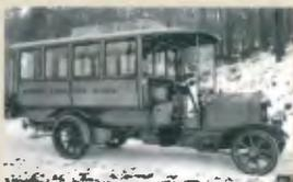
**1911** - A nova empresa Scania-Vabis lança o primeiro ônibus com motor construído na Suécia, o "ônibus Nordmark". Equipado com um chassi propulsionado a correntes construído pela Scania e um motor e uma carroceria da Vabis, o ônibus Nordmark representa um novo padrão em termos de transportes públicos.
