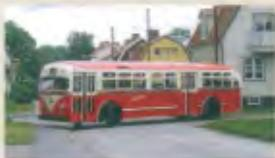
**1953** - A fabricante apresenta ao mercado sueco o ônibus suburbano Scania-Vabis Metropol, desenvolvido em colaboração com a Mack dos Estados Unidos. Com um motor traseiro de 8 cilindros, é o primeiro ônibus completamente construído na Suécia com uma carroceria monobloco.
