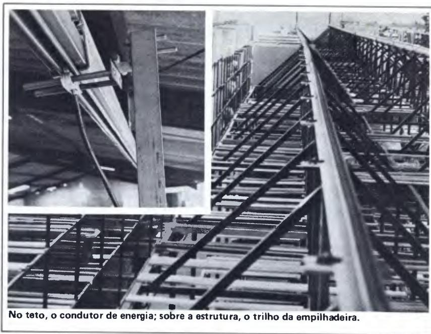
No teto, o condutor de energia; sobre a estrutura, o trilho da empilhadeira.
