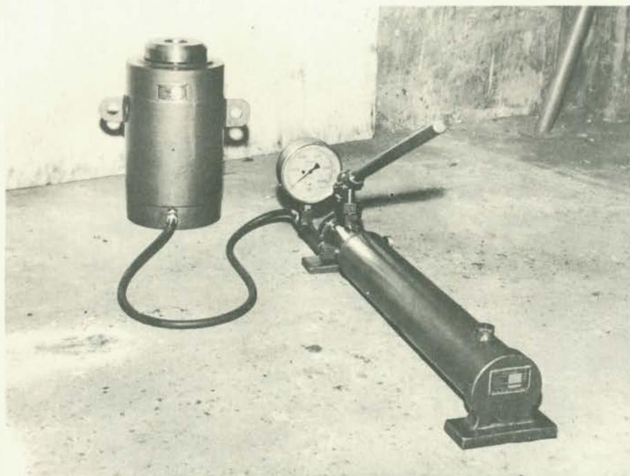
**MACACO INDUSTRIAL** — Hidráulico, com capacidade de 10 a 700 t. Utilizado para levantamento de pequenas e grandes cargas, tais como tornos, prensas, teares, locomotivas, navios, prédios, viadutos, pontes. Comandados à distância, por meio de bomba, êsses macacos são utilizados na construção civil. **Serviço de Consulta n.º 5.**
