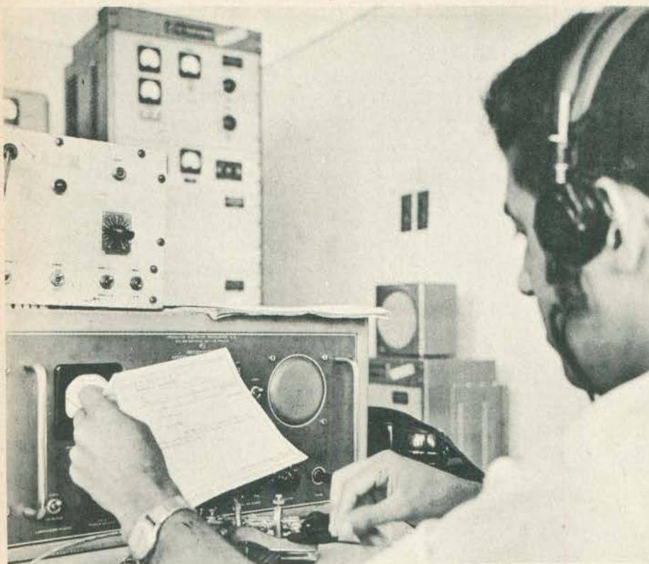
**ININTERRUPTO** — Durante as 24 horas de cada dia, as estações da Viação Cometa permanecem no ar. Três sistemas estão em funcionamento: CW, VHF e SSB.
