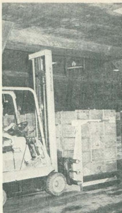
Figura 10: Abraçadores para caixas
