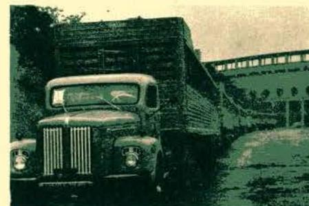
**CARROCERIA PARA GADO** — Trinta cabeças de gado viajam confortavelmente (com água corrente e tudo) neste semi-reboque Trivellato. O semi-reboque dispõe, ainda, de um sistema para alimentação do gado. O conforto proporcionado elimina as perdas de peso, comuns nessas viagens. Para dar maior firmeza ao gado, o assoalho do semi-reboque é constituído por tábuas e sarrafos em forma de xadrez. Para informações, marque o n.º 14 do Serviço de Consulta, na página 73.
