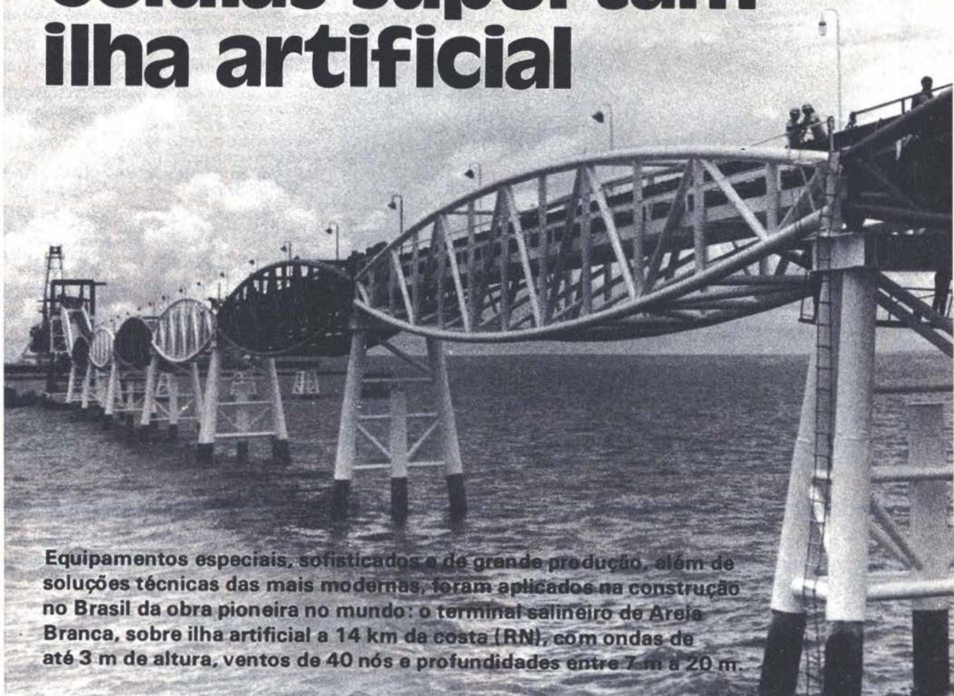
**Equipamentos especiais, sofisticados e de grande produção, além de soluções técnicas das mais modernas, foram aplicados na construção no Brasil da obra pioneira no mundo: o terminal salineiro de Areia Branca, sobre ilha artificial a 14 km da costa (RN), com ondas de até 3 m de altura, ventos de 40 nós e profundidades entre 7 m a 20 m.**
